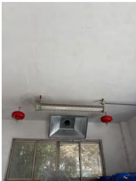
危废仓库防爆灯及废气收集装置
